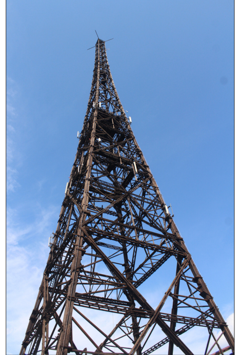
Detailansicht des Turms des Senders Gleiwitz mit Antennen für Mobilfunk, BOS-Funk und Rundfunk
