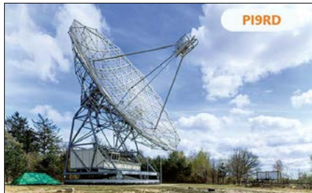
Der 25-m-Spiegel in Dwingeloo stammt bereits aus dem Jahr 1956 (letzte Restaurierung 2013) und wird von PI9RD für EME-Versuche benutzt. Foto: CAMRAS
