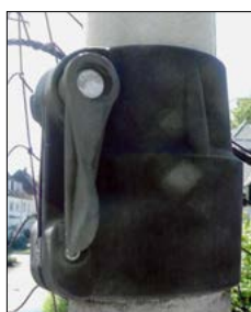
Bild 6: Die Besonderheit der VDL-Masten waren neben der mechanischen Stabilität die einfach zu bedie- nende Klemm- halterung für jedes Segment.
