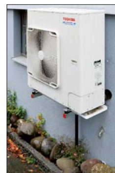
Außengerät einer Luft-Wasser-Wärmepumpe
