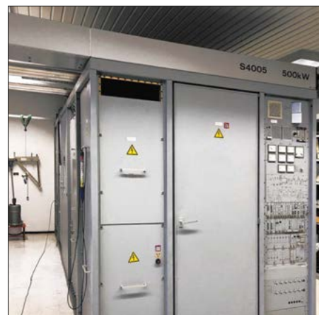
Bild 2: Telefunken/AEG-KW-Sender vom Typ S 4005 mit 500 kW Sendeleistung
