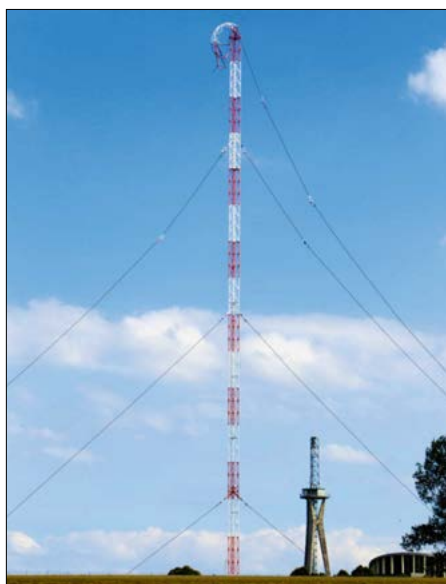
Sendemast von Europe 1 mit abgebrochener Spitze Foto: Hoschdebacha, CC BY-SA 3.0
