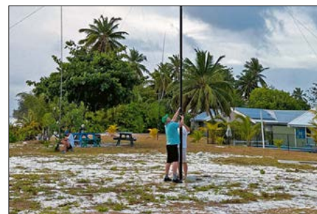
Aufbau der 160-m-Vertikalantenne auf sandigem Boden
