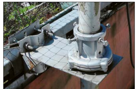
Bild 4: Eine Rotorplattform und ein Oberlager fixieren den drehbaren Mast.
