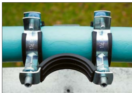
Bild 4: Vorbereitete, an der Balkonbrüstung montierte obere Masthalterung ...
