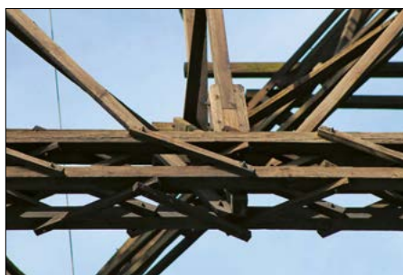
Detailansicht eines Fachwerkträgers des Sendeturms
