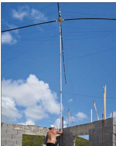
Einen unserer Spiderbeams montierten wir an der Mauer eines Rohbaus.
