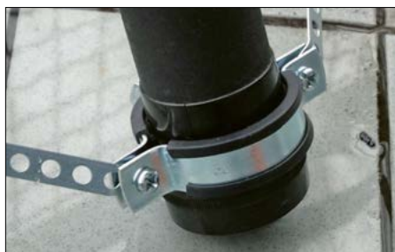
Bild 10: Die untere Halterung umschließt die Kunststoffhülse des Masts.
