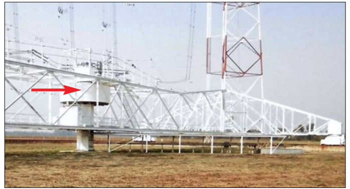
Bild 6: Antriebsanlage und zentraler Lager- punkt (Pfeil) der Drehstandantenne des Senders Moosbrunn
