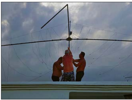
Reparatur des Spiderbeams, den heftige Windböen beschädigt hatten
