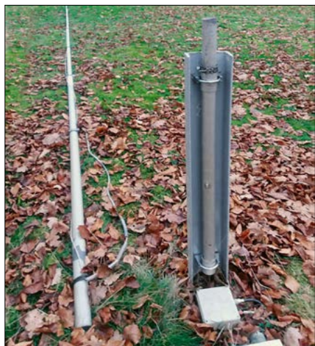
Bild 1: Masthalterung aus verzinktem U-Profil; auf das Aluminiumrohr wird der Teleskopmast (links) gesteckt. Foto: DK6ED
